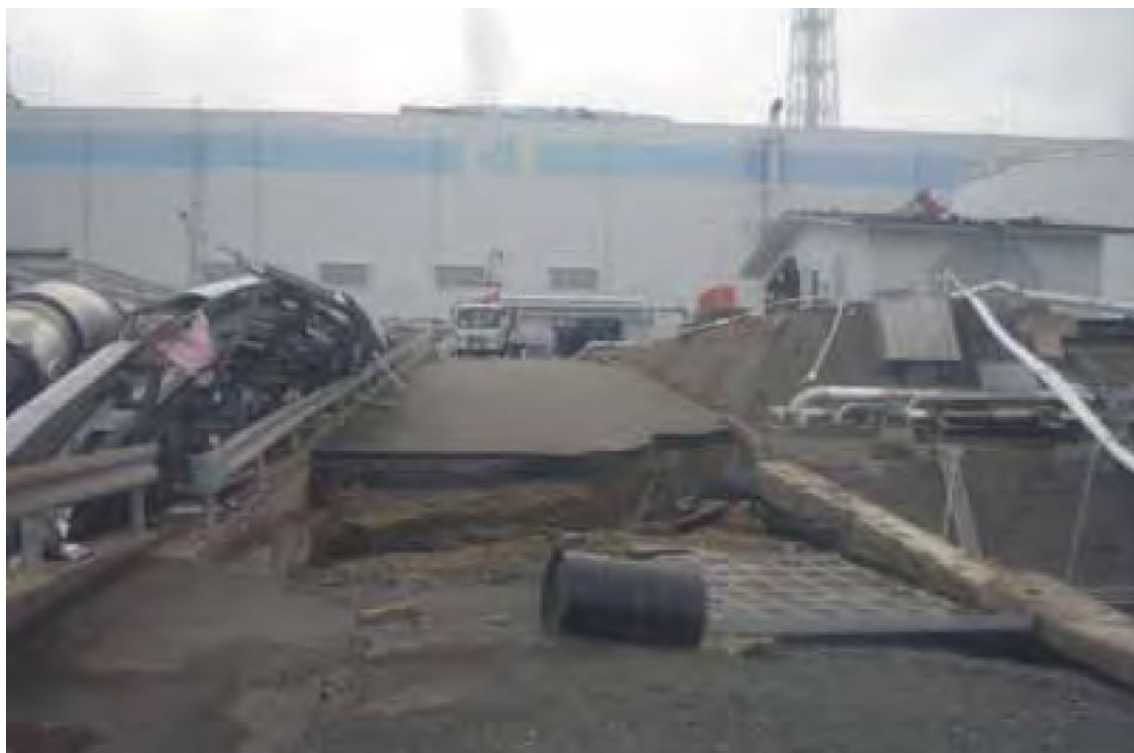
東北地方太平洋沖地震によって損壊した福島第一原発構内の道路
